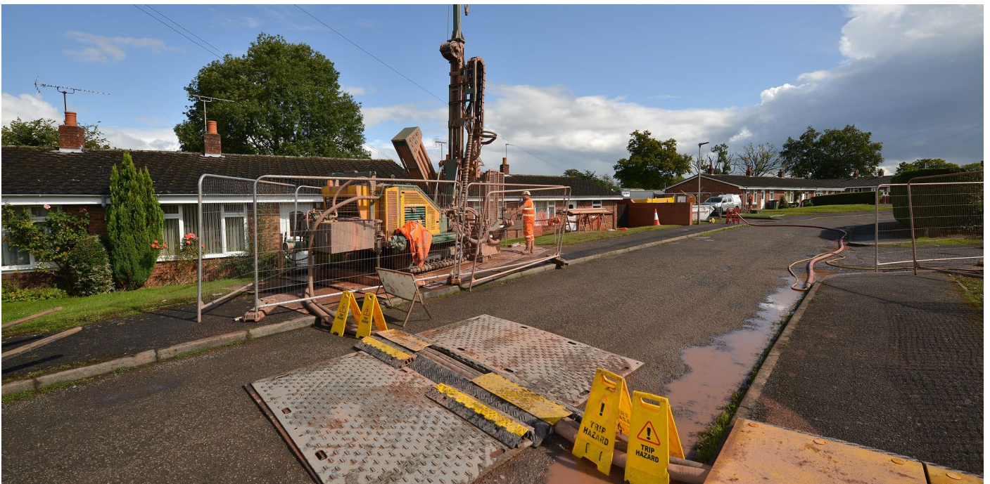
공용 지열 히트펌프 시스템 설치를 위한 지중 굴착 작업 현장. 자료: Kensa Heat Pumps.
