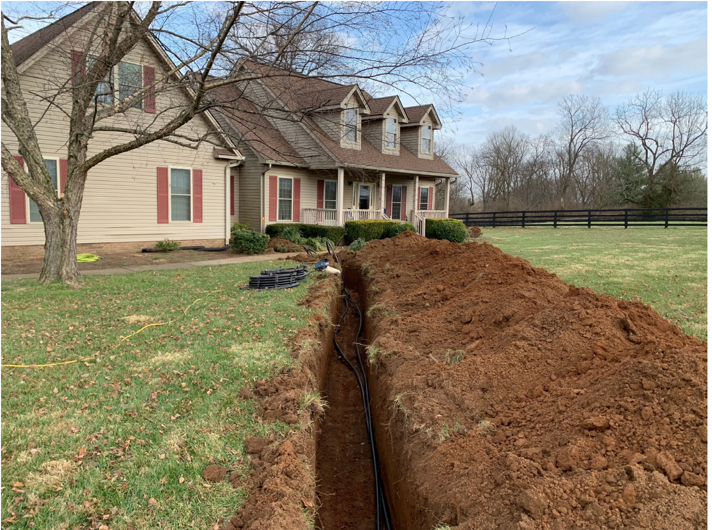
지열 히트펌프 지중 열 교환기(ground array) 설치를 위한 굴착 트렌치. 자료: Danielsen_Photography/Shutterstock.
