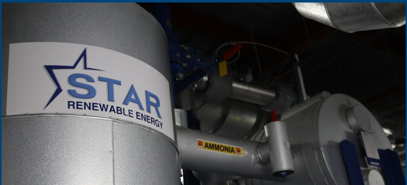
브리스톨 캐슬 파크 히트펌프의 내부 이미지. 자료: Star Renewables.
