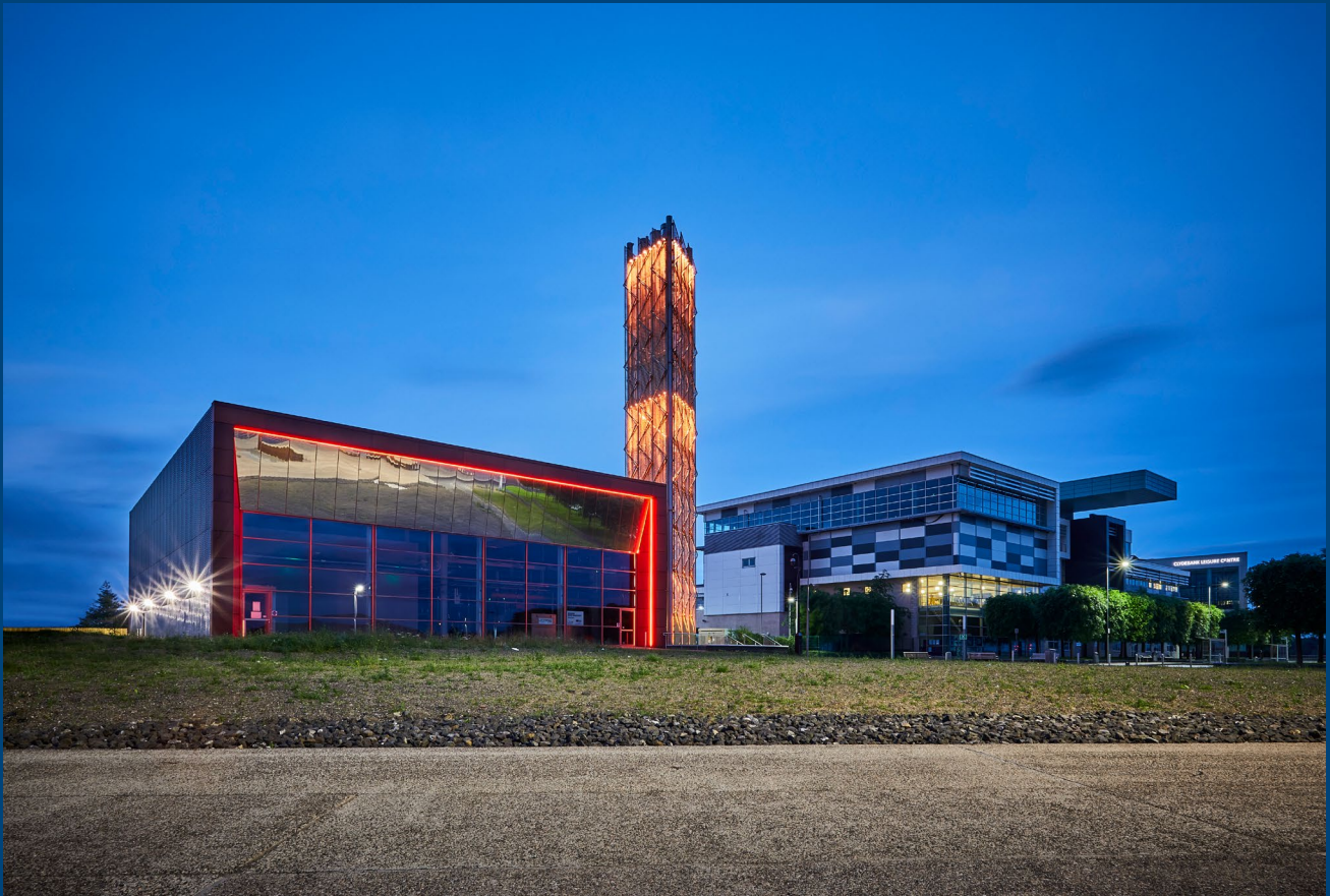
코틀랜드 글래스고 퀸즈 콰이 5.2MW 수열 히트펌프. 자료: Star Renewables. 스
